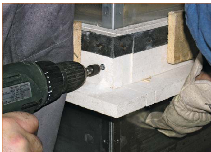
Abb. 3: Montage eines Einbau-Rahmens außerhalb der Wand
