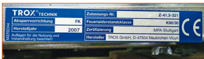
Abb. 2: Typenschild einer Brandschutzklappe mit Zulassungsnummer
